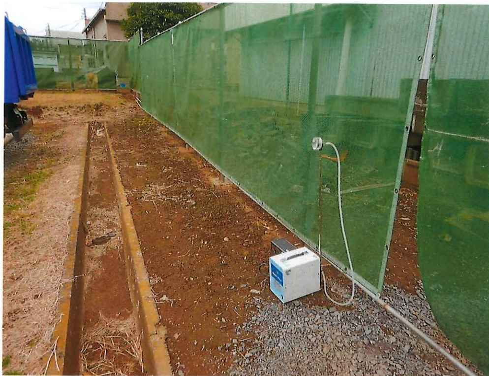
令和5年12月19日 粉じん濃度 敷地境界(風下) 測定状況
