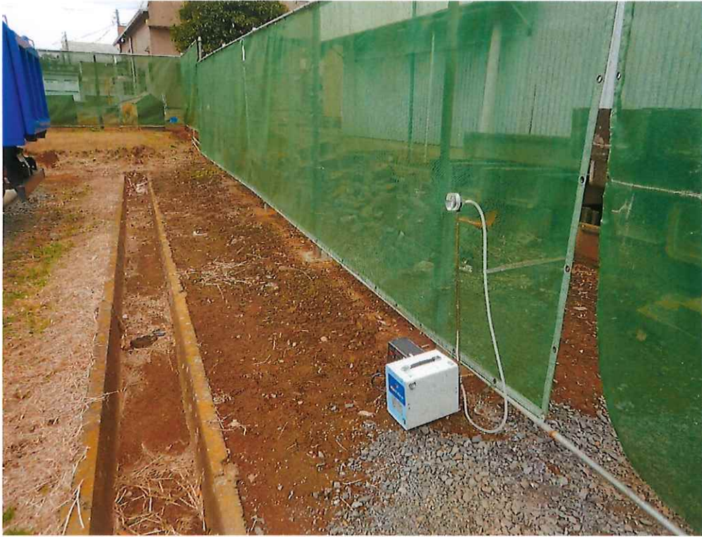
敷地境界(風下)測定状況
